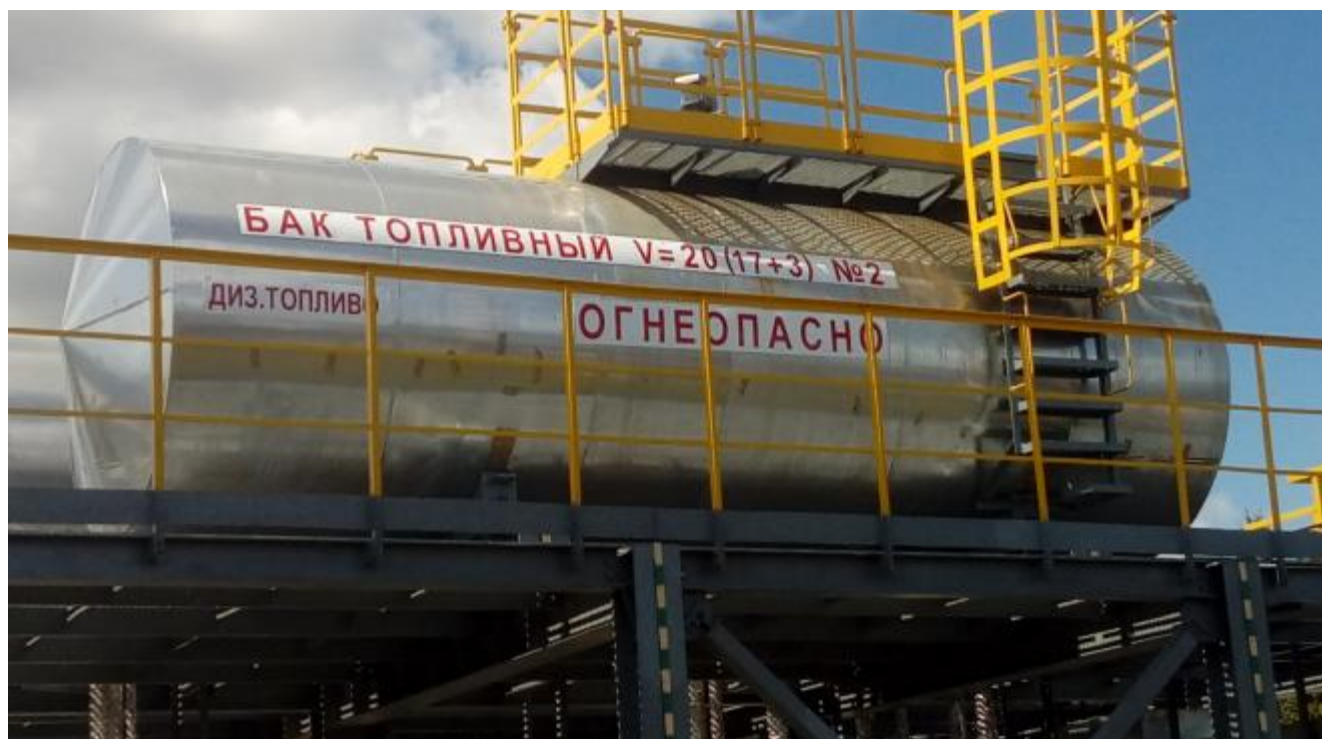
Рисунок 1 – Общий вид резервуара РГС-20
