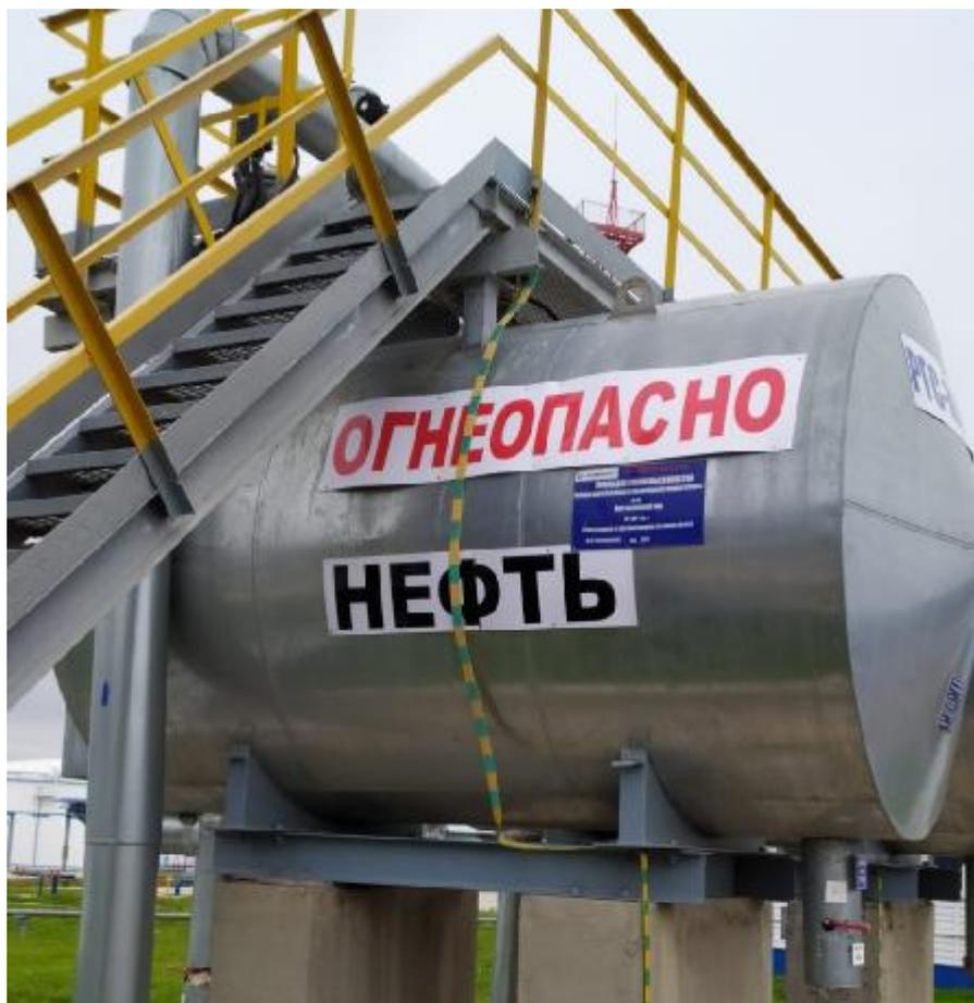
Рисунок 1 – Общий вид резервуаров стальных горизонтальных цилиндрических РГС-10
