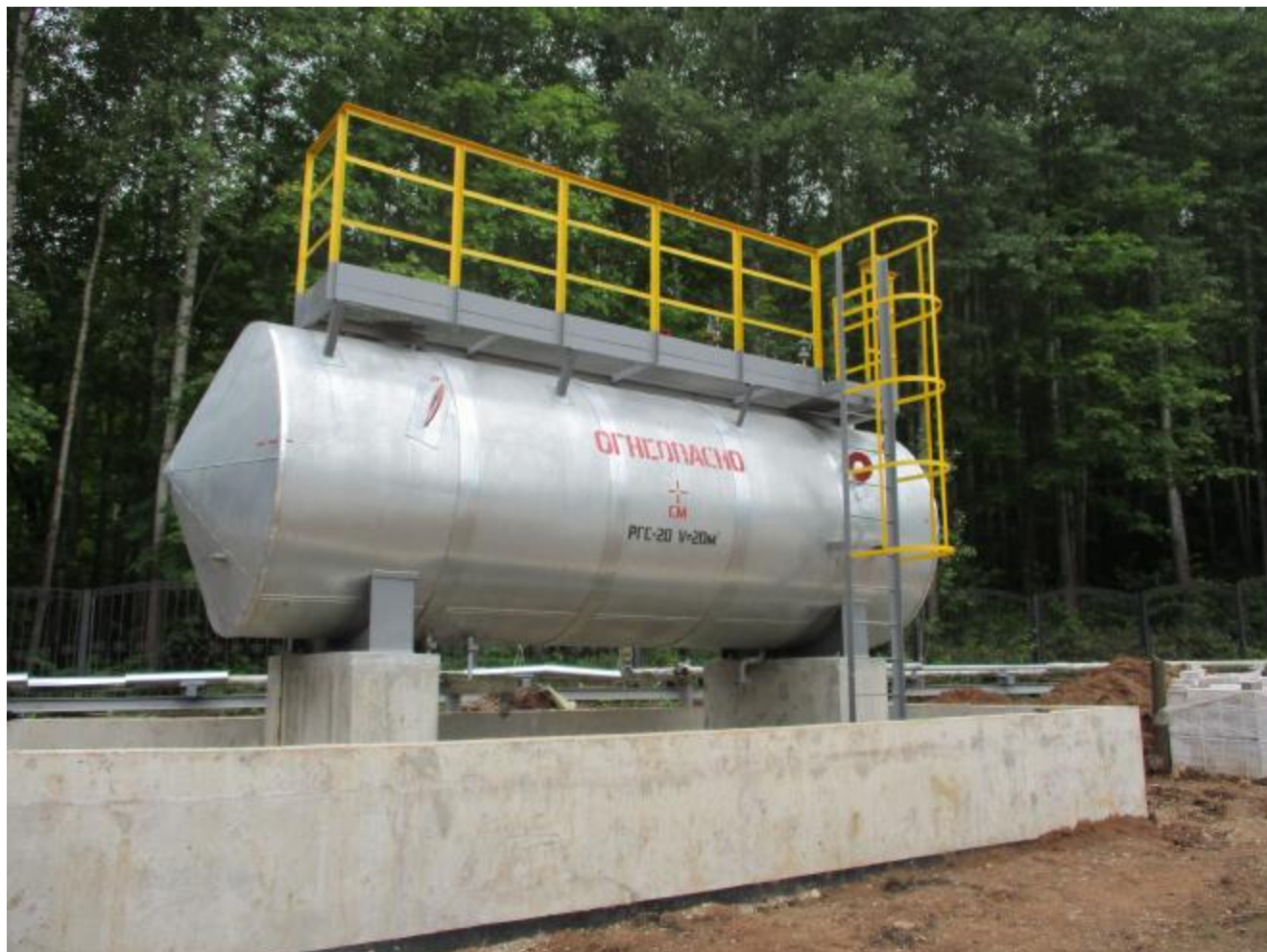
Рисунок 1 – Общий вид резервуара РГС-20
