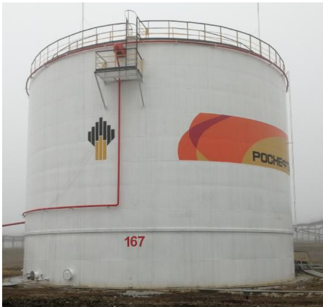
Рисунок 1 – Общий вид резервуара стального вертикального цилиндрического РВС-5000
