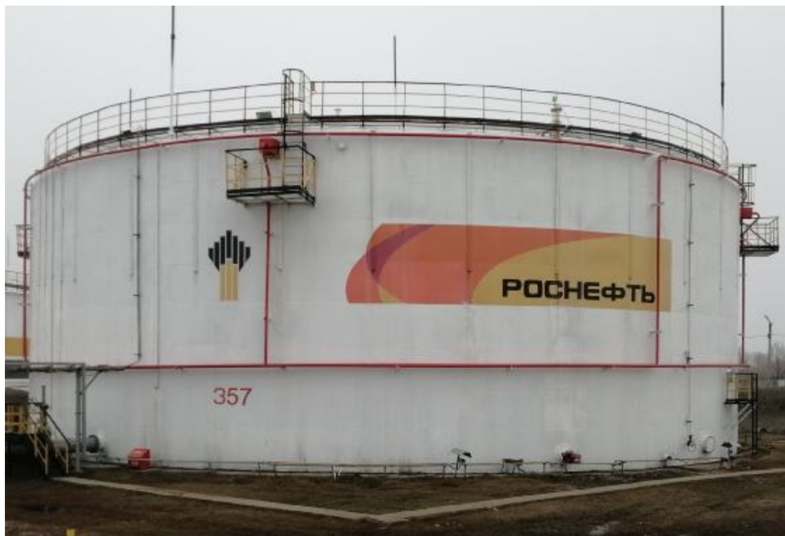
Рисунок 2 – Общий вид резервуара стального вертикального цилиндрического РВС-10000
