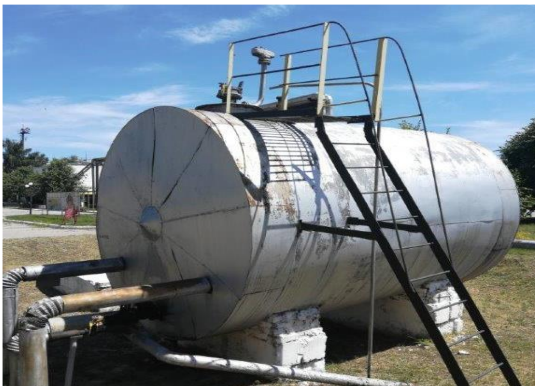
Рисунок 1 – Общий вид резервуара стального горизонтального цилиндрического РГС-25
