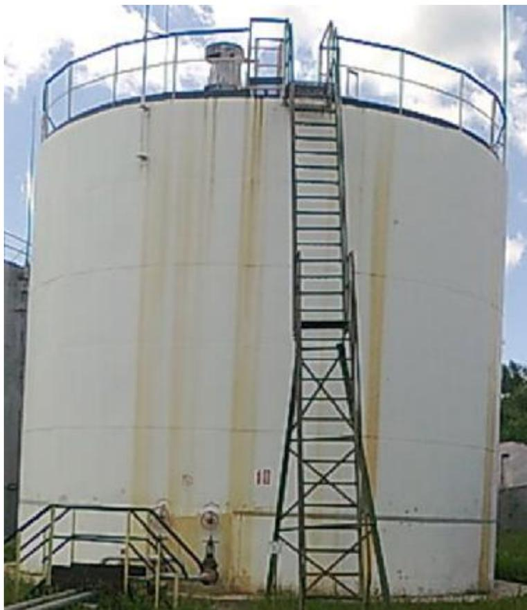
Рисунок 1 – Общий вид резервуара стального вертикального цилиндрического РВС-700
