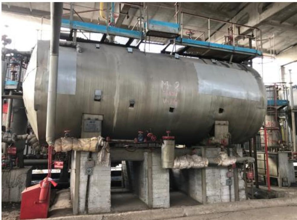
Рисунок 1 – Общий вид резервуара горизонтального стального цилиндрического РГС-50
