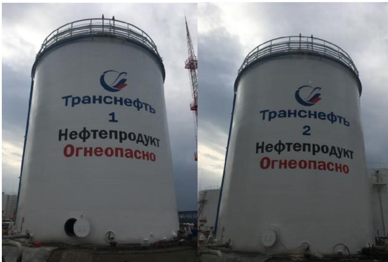
Рисунок 1 – Общий вид резервуаров стальных вертикальных цилиндрических РВС-1000
