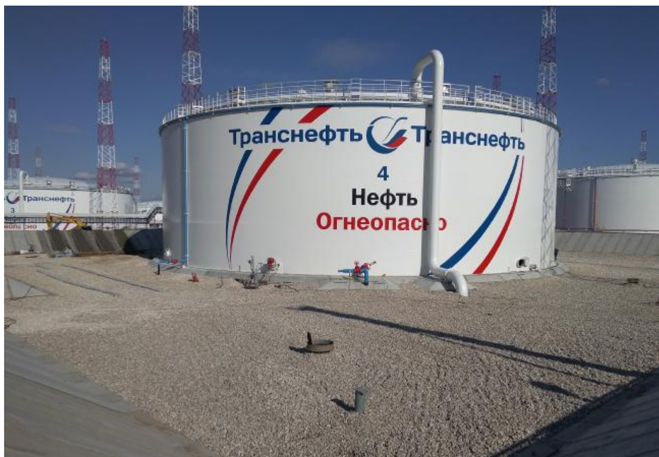
Рисунок 1 – Общий вид резервуара РВС-20000
