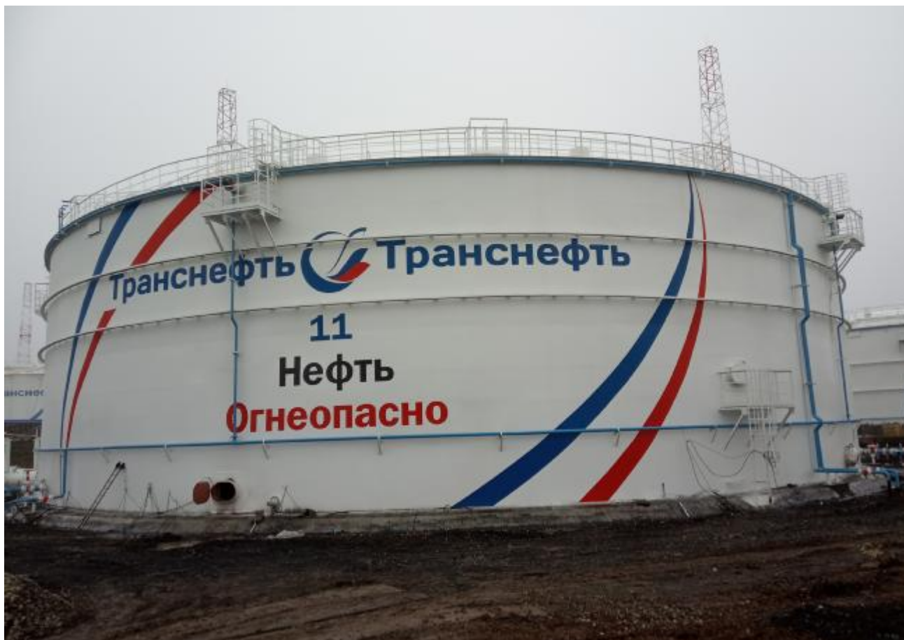
Рисунок 1 – Общий вид резервуара РВСП-20000
