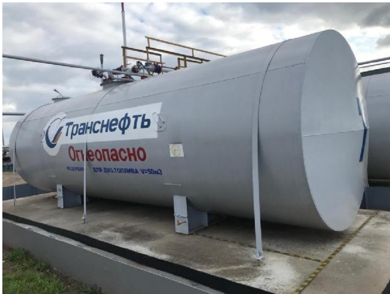
Рисунок 1 – Общий вид резервуара РГС-50
