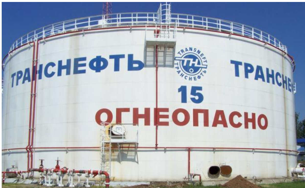
Рисунок 1 – Общий вид резервуара РВСП-10000
