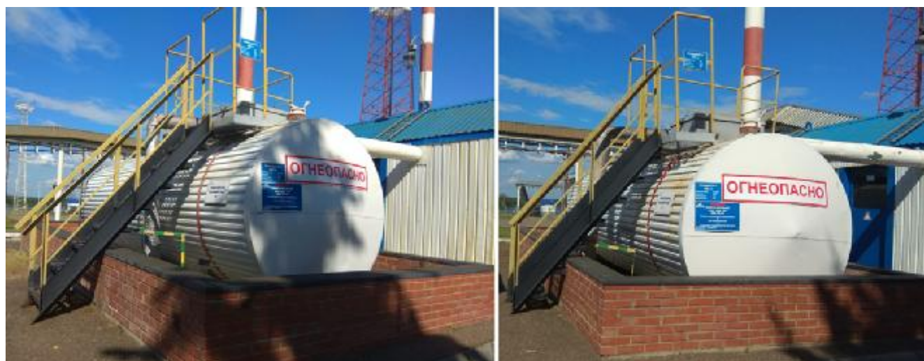
Рисунок 3 – Общий вид резервуаров РГС-20 (17+3) зав. №№ 6194 11/36, 6194 12/36
