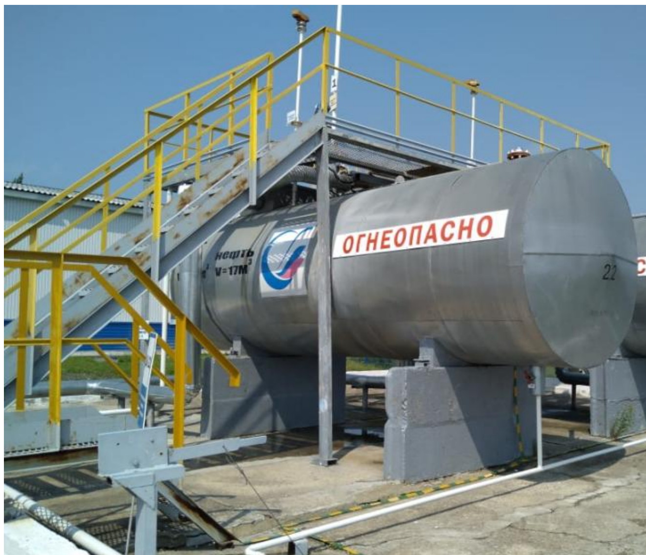
Рисунок 2 – Общий вид резервуара РГС-20 (17+3) зав. № 6194
