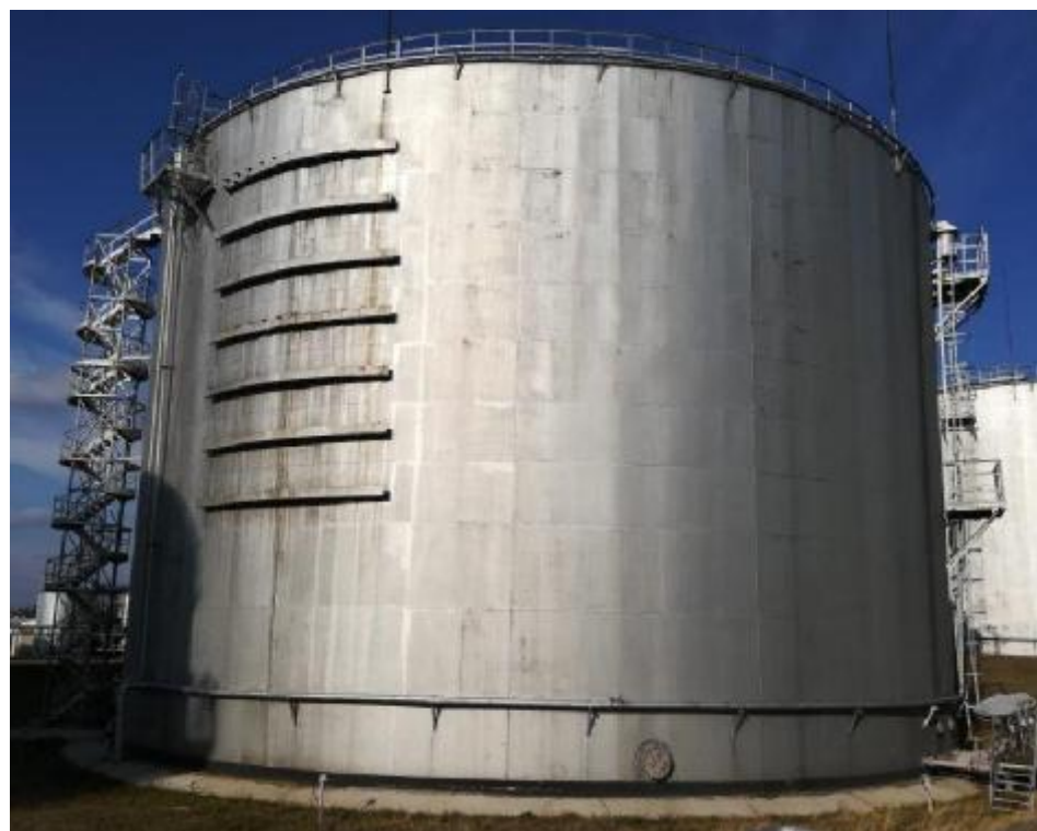
Рисунок 5 – Общий вид резервуара стального вертикального цилиндрического РВС-10000
