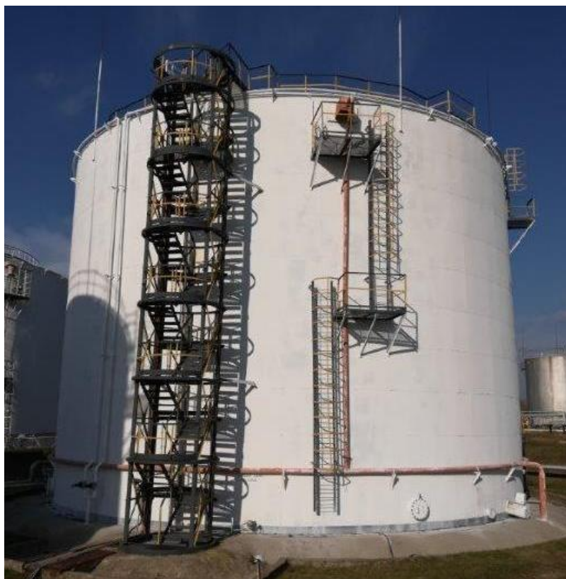
Рисунок 4 – Общий вид резервуара стального вертикального цилиндрического РВСП-5000
