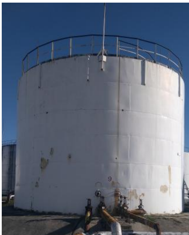
Рисунок 1 – Общий вид резервуара стального вертикального цилиндрического РВС-1000
