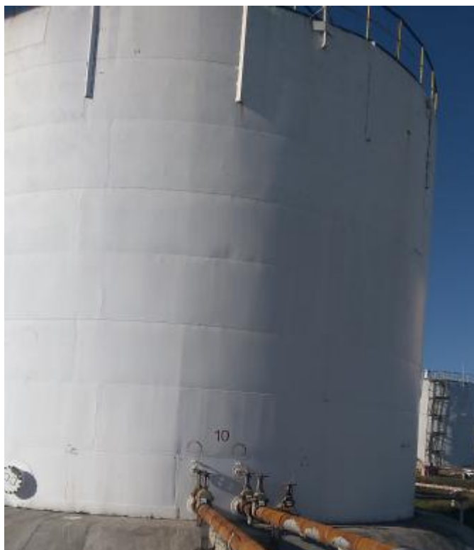
Рисунок 2 – Общий вид резервуара стального вертикального цилиндрического РВС-2000
