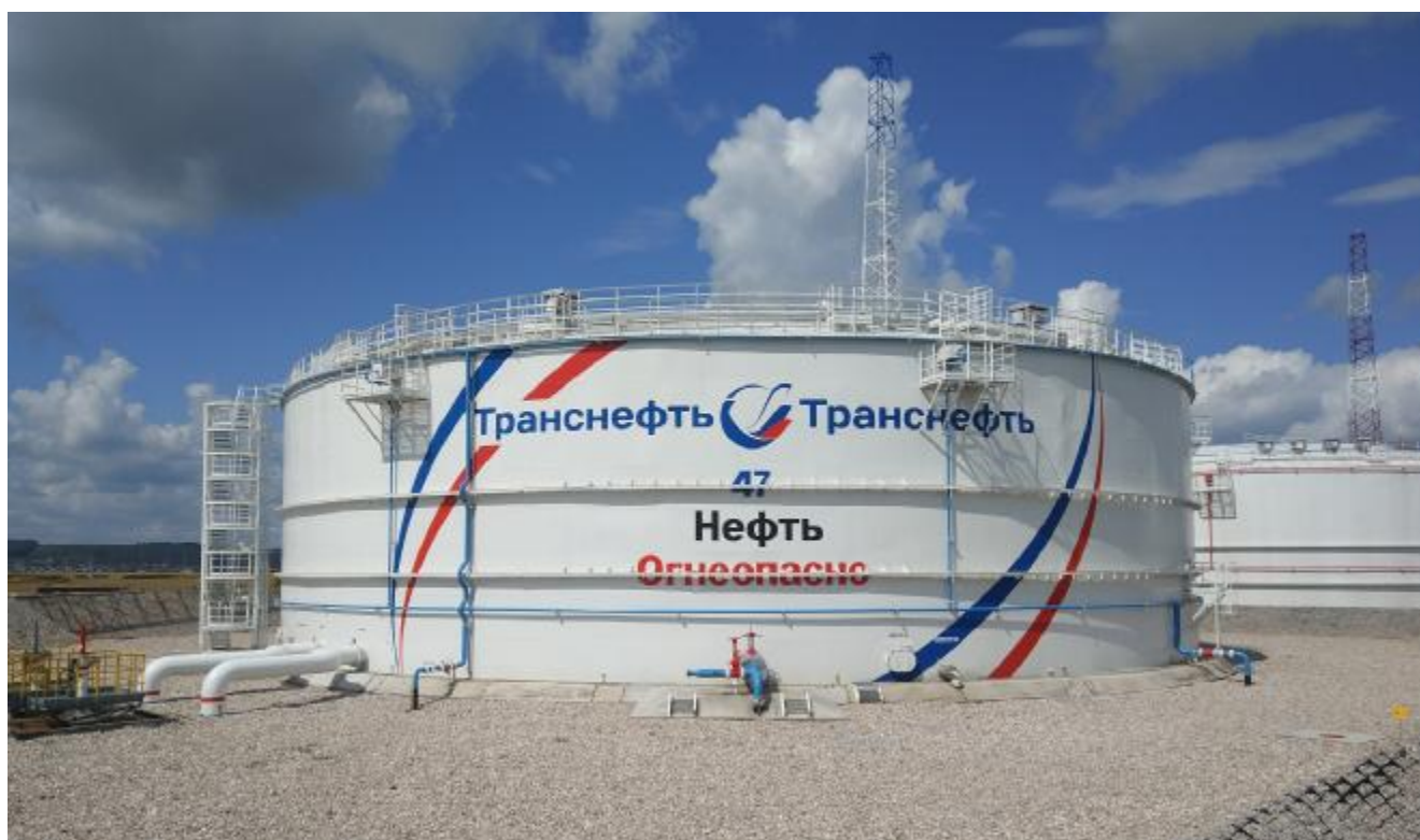
Рисунок 1 – Общий вид резервуара РВС-20000
