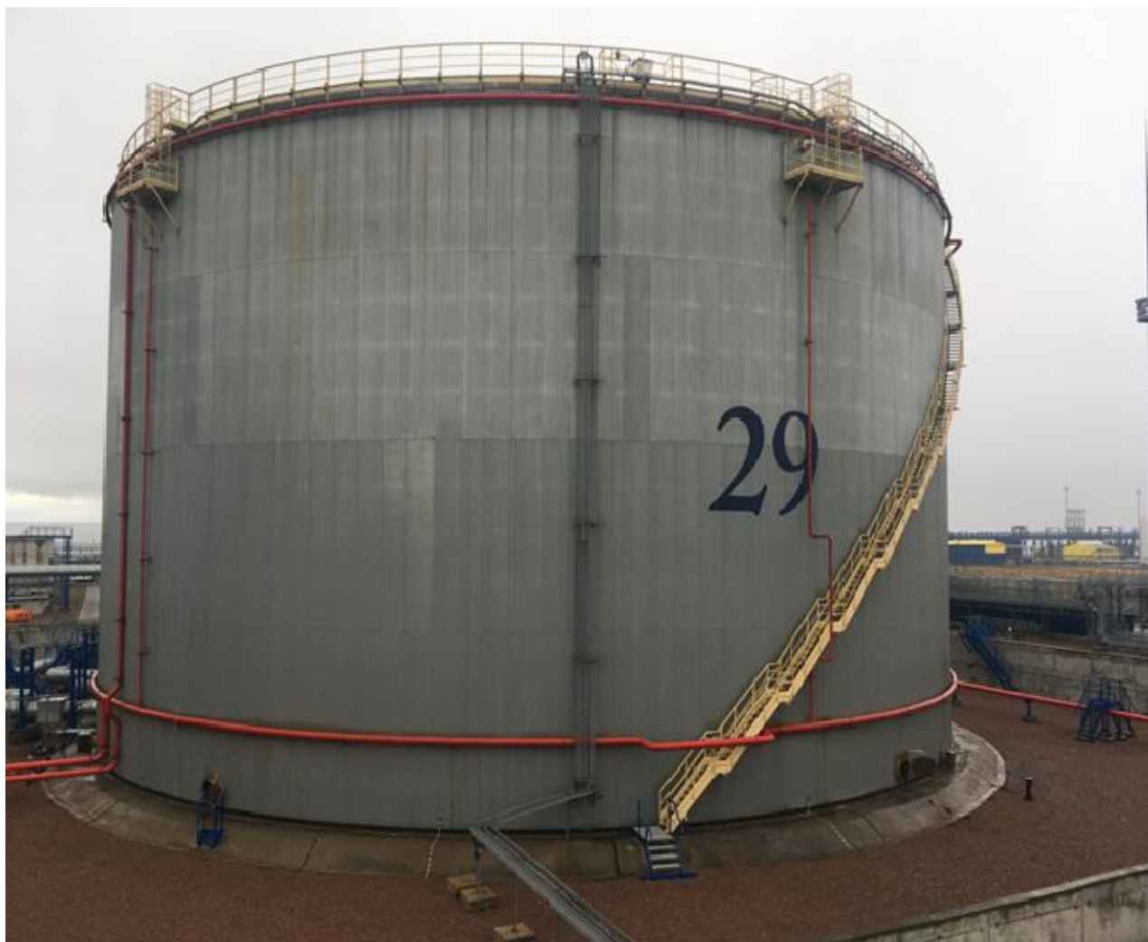
Рисунок 2 – Общий вид резервуара РВС-40000
