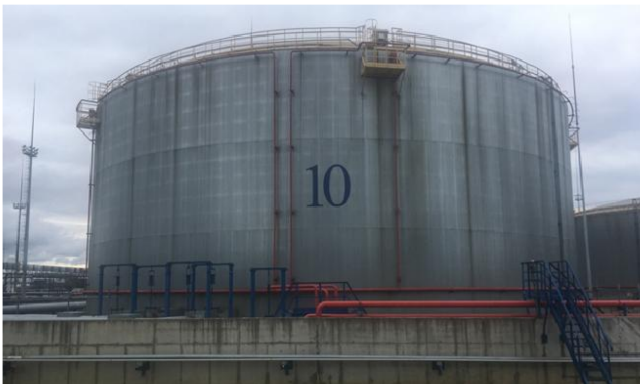
Рисунок 1 – Общий вид резервуара РВС-30000
