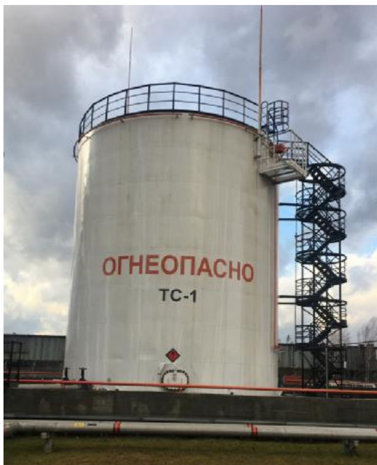
Рисунок 1 – Резервуар стальной вертикальный РВС-1000
