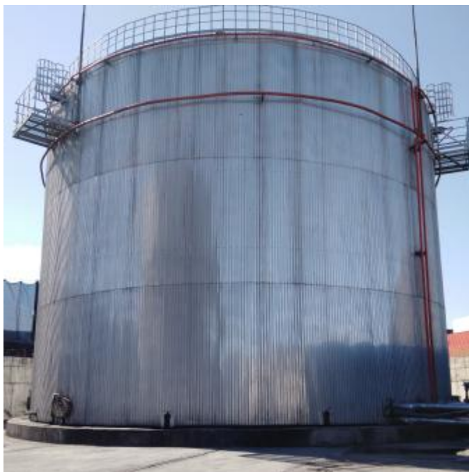
Рисунок 1 – Общий вид резервуара
