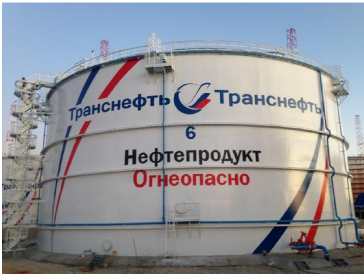
Рисунок 1 – Общий вид резервуара стального вертикального цилиндрического РВСП-20000
