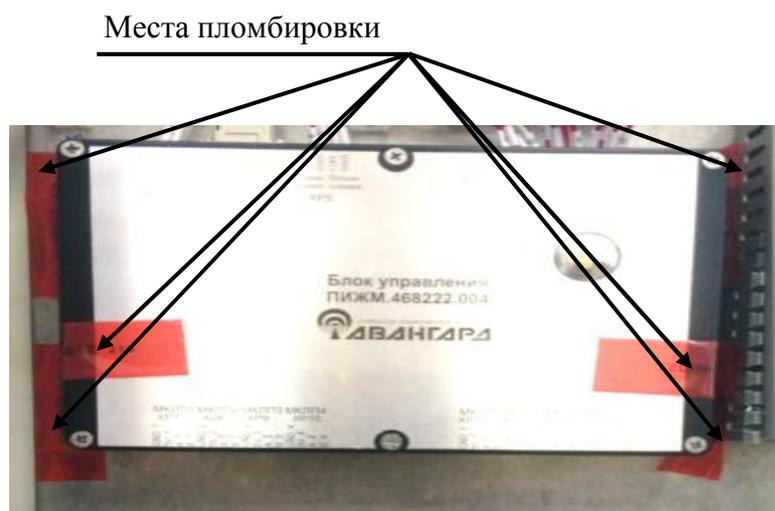
Рисунок 4 – Пломбировка БУ
