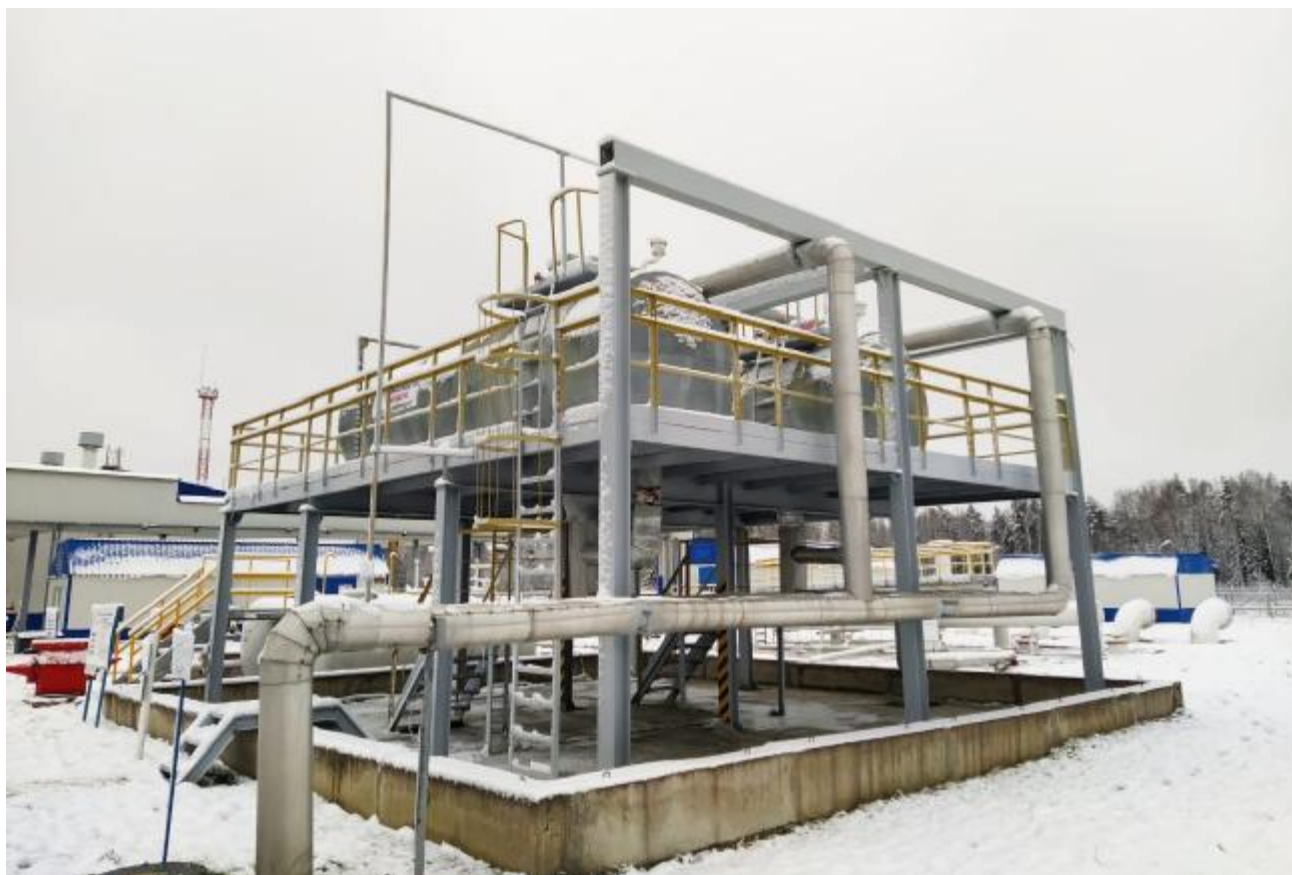
Рисунок 1 – Общий вид резервуаров РГС-20
