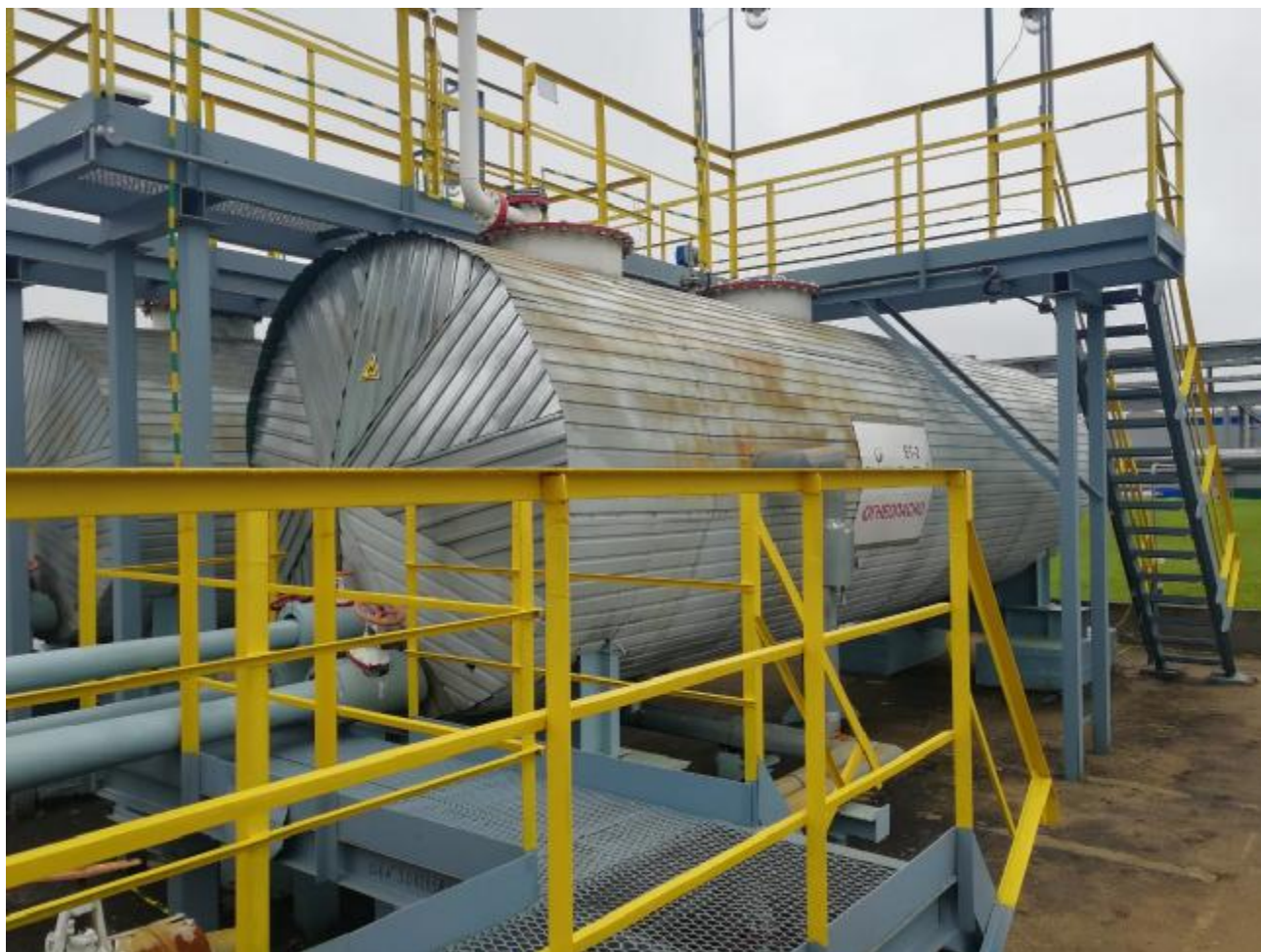
Рисунок 1 – Общий вид резервуаров РГС-40
