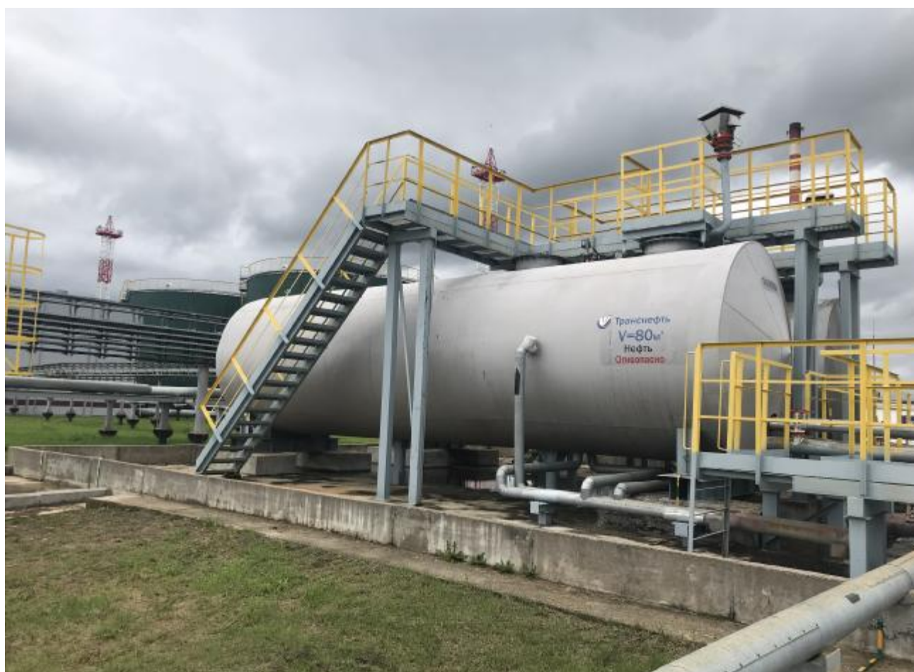
Рисунок 1 – Общий вид резервуара РГС-80
