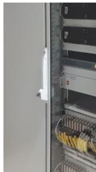
Рисунок 8 – Замок двери стойки приборной АИИС. Вид внешний
