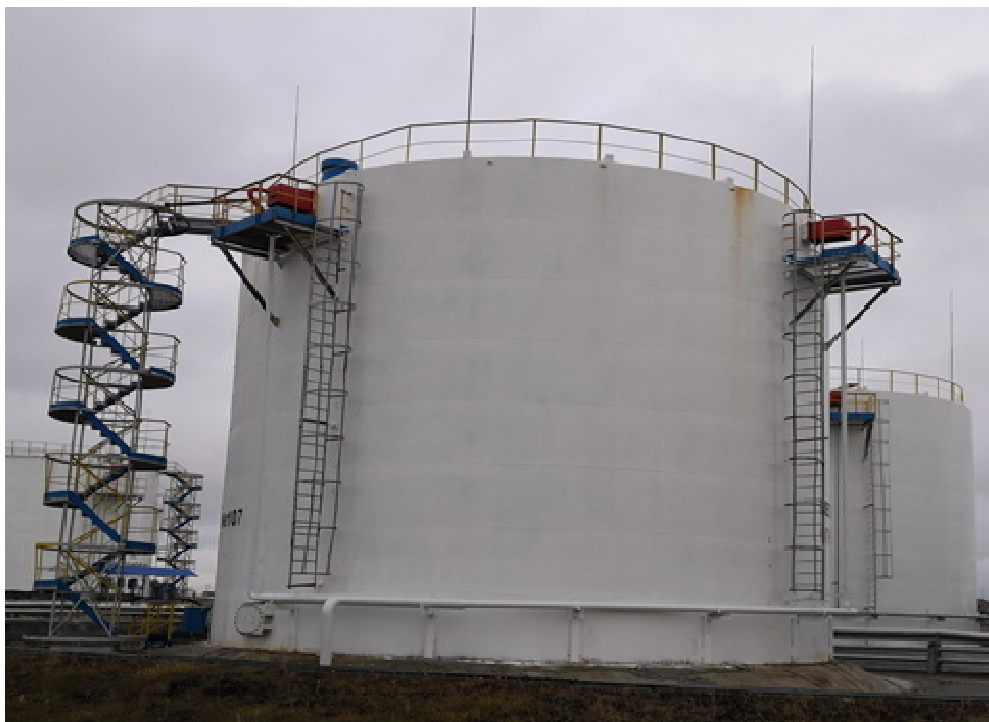
Рисунок 1 – Общий вид резервуара вертикального стального цилиндрического РВС-2000
