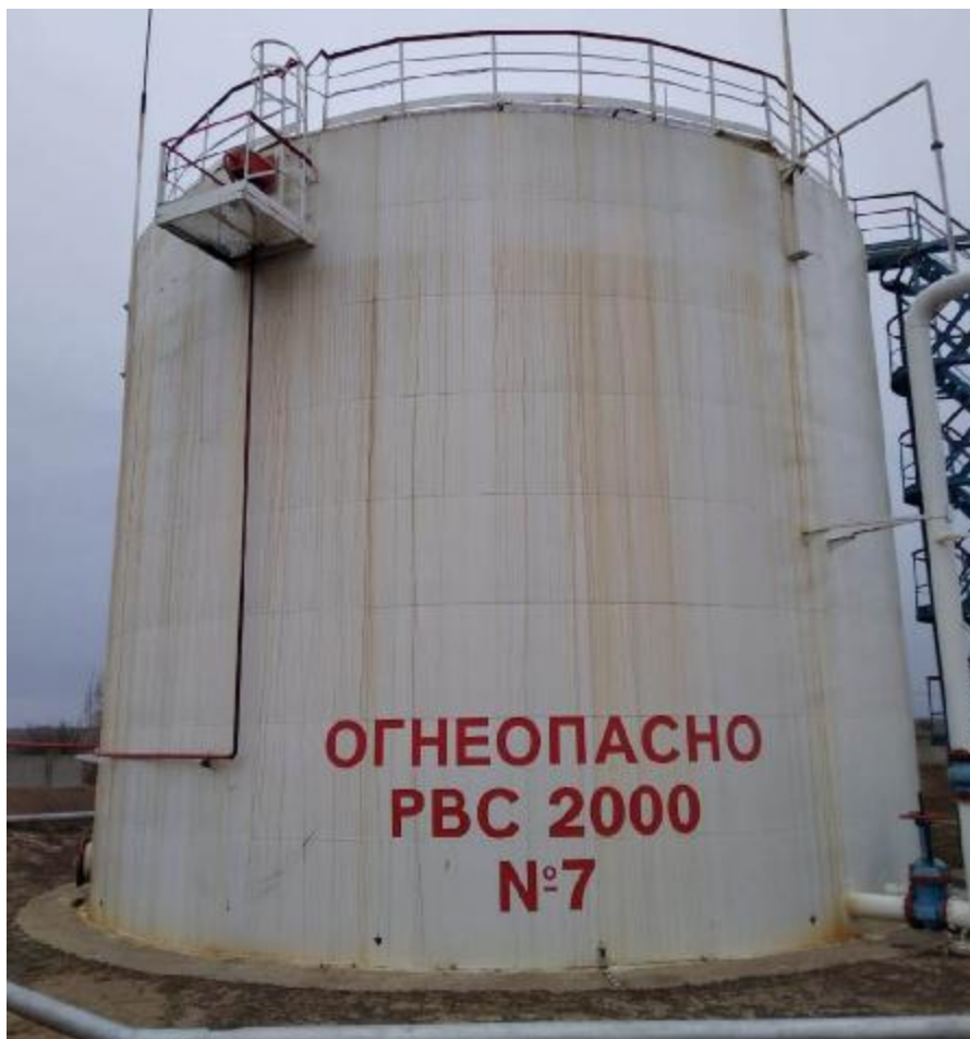
Рисунок 2 – Резервуар вертикальный стальной РВС-2000
