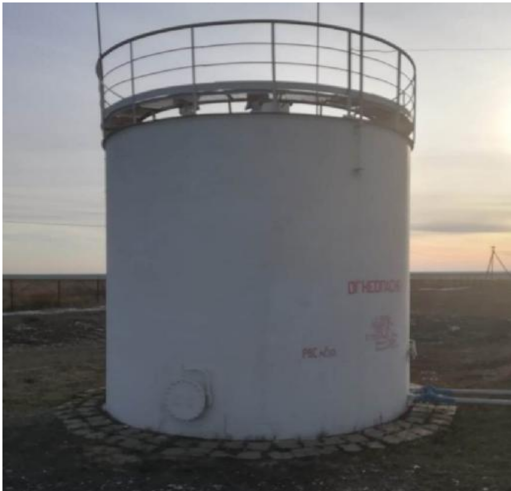
Рисунок 1 – Резервуар вертикальный стальной РВС-200
