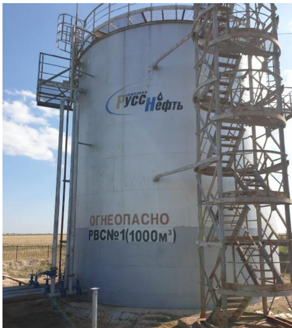
Рисунок 1 – Резервуар вертикальный стальной РВС-1000
