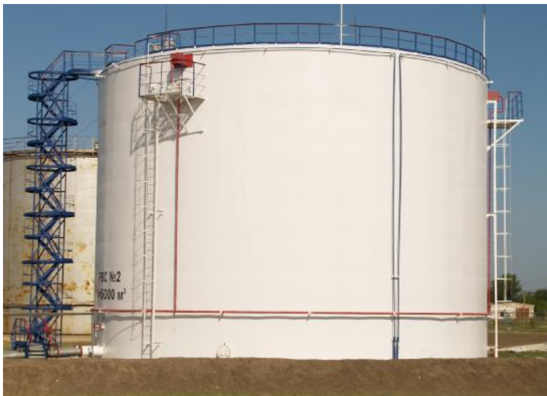
Рисунок 4 – Резервуар вертикальный стальной РВС-5000
