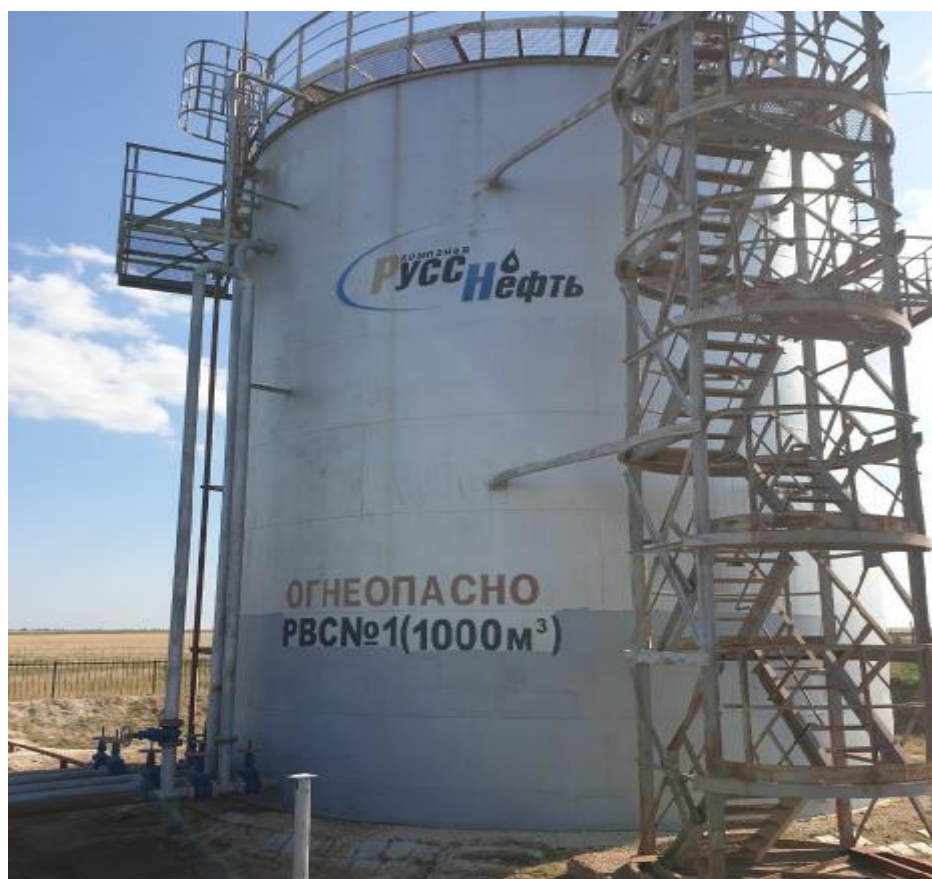
Рисунок 2 – Резервуар вертикальный стальной РВС-1000
