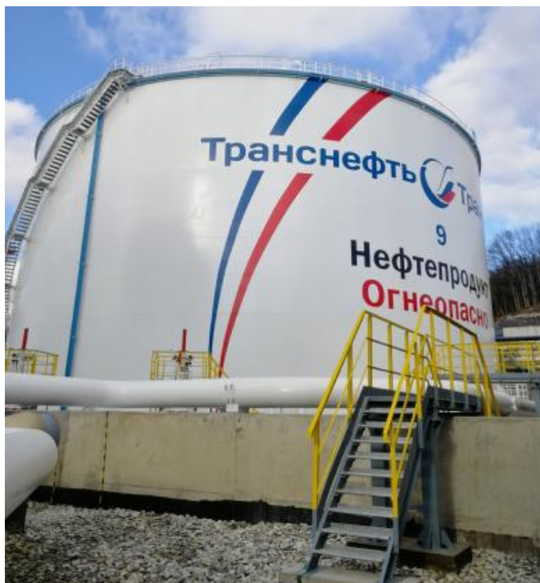
Рисунок 1 - Общий вид резервуаров стальных вертикальных цилиндрических РВС-30000
