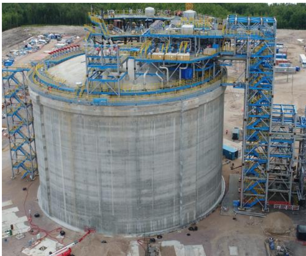
Рисунок 1 – Общий вид резервуара РВС-42000
