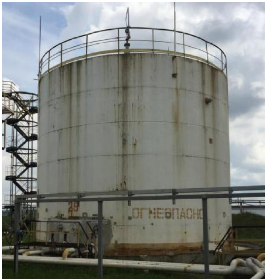
Рисунок 1 – Общий вид резервуаров стальных вертикальных цилиндрических РВСП-700
