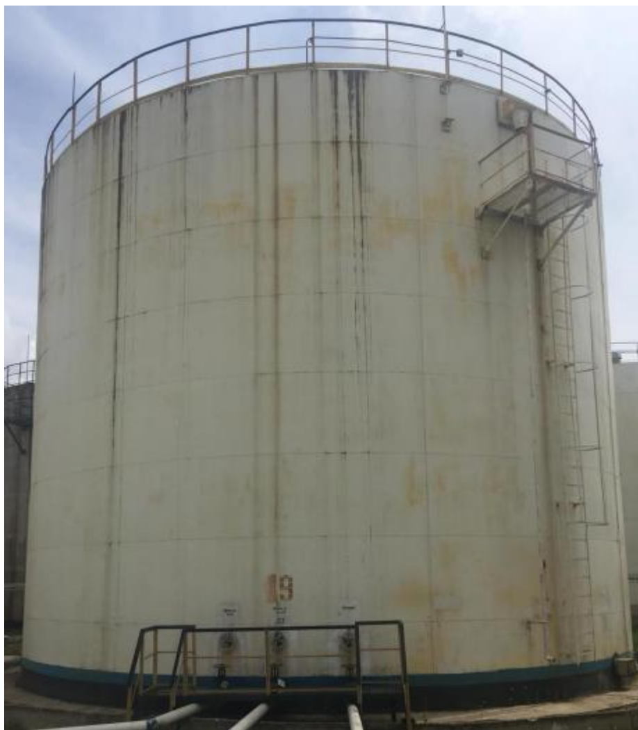
Рисунок 1 – Общий вид резервуаров стальных вертикальных цилиндрических РВС-2000
