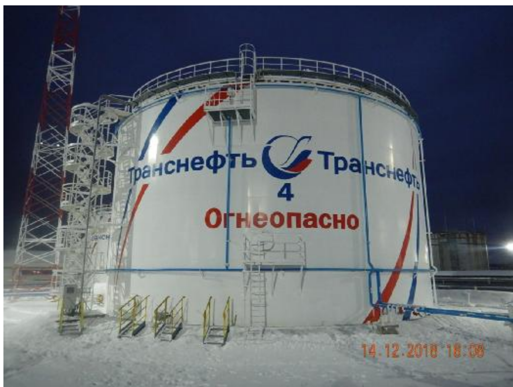
Рисунок 1 – Общий вид резервуара РВСП-5000 зав.№ 4
