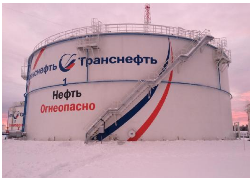
Рисунок 2 – Общий вид резервуара РВС-10000 зав.№ 1
