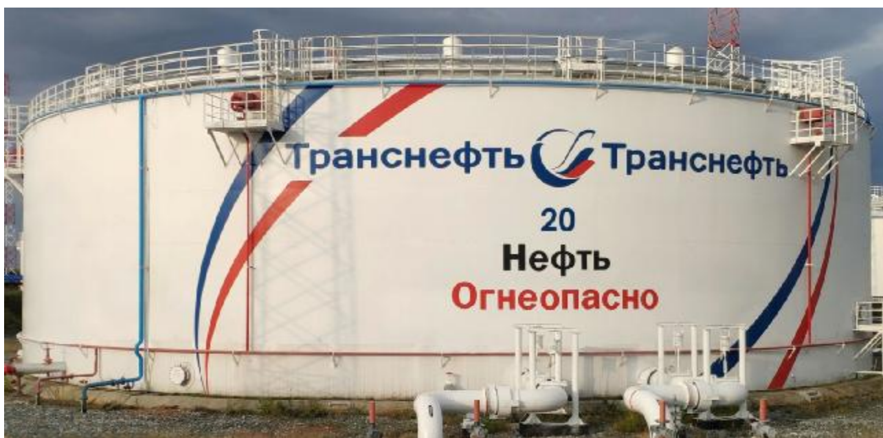
Рисунок 1 – Общий вид резервуара РВСП-20000 зав.№ 20
