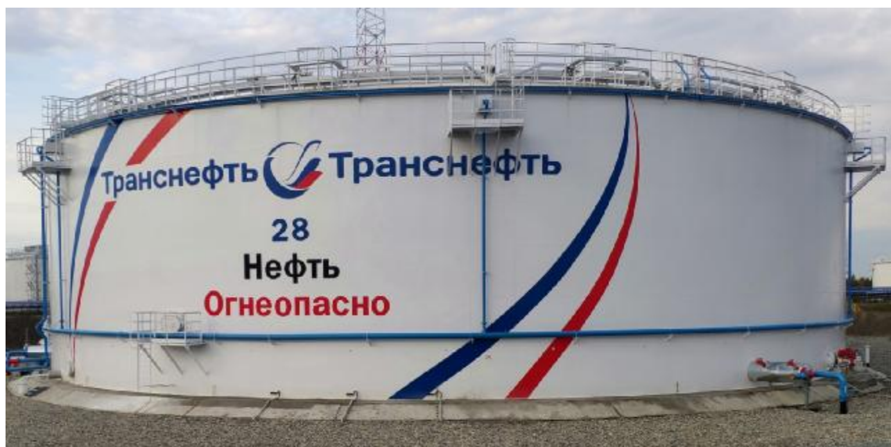
Рисунок 1 – Общий вид резервуара РВСП-20000 зав.№ 28
