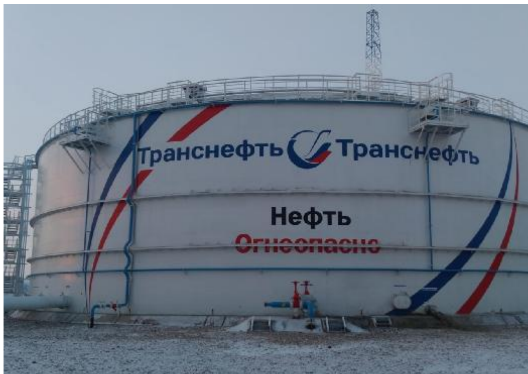
Рисунок 2 – Общий вид резервуаров РВС-20000 зав.№№ 32, 47
