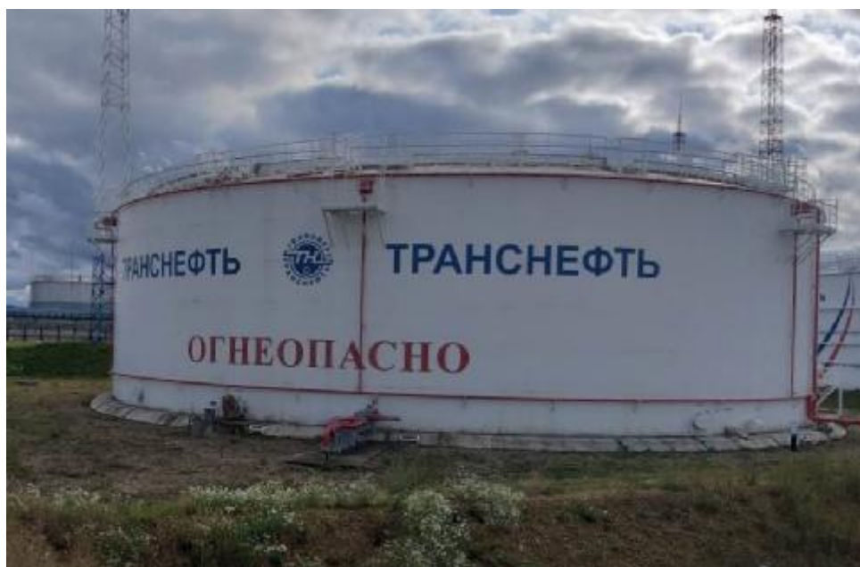
Рисунок 1 – Общий вид резервуаров РВСП-20000 зав.№№ 35, 36, 41, 42
