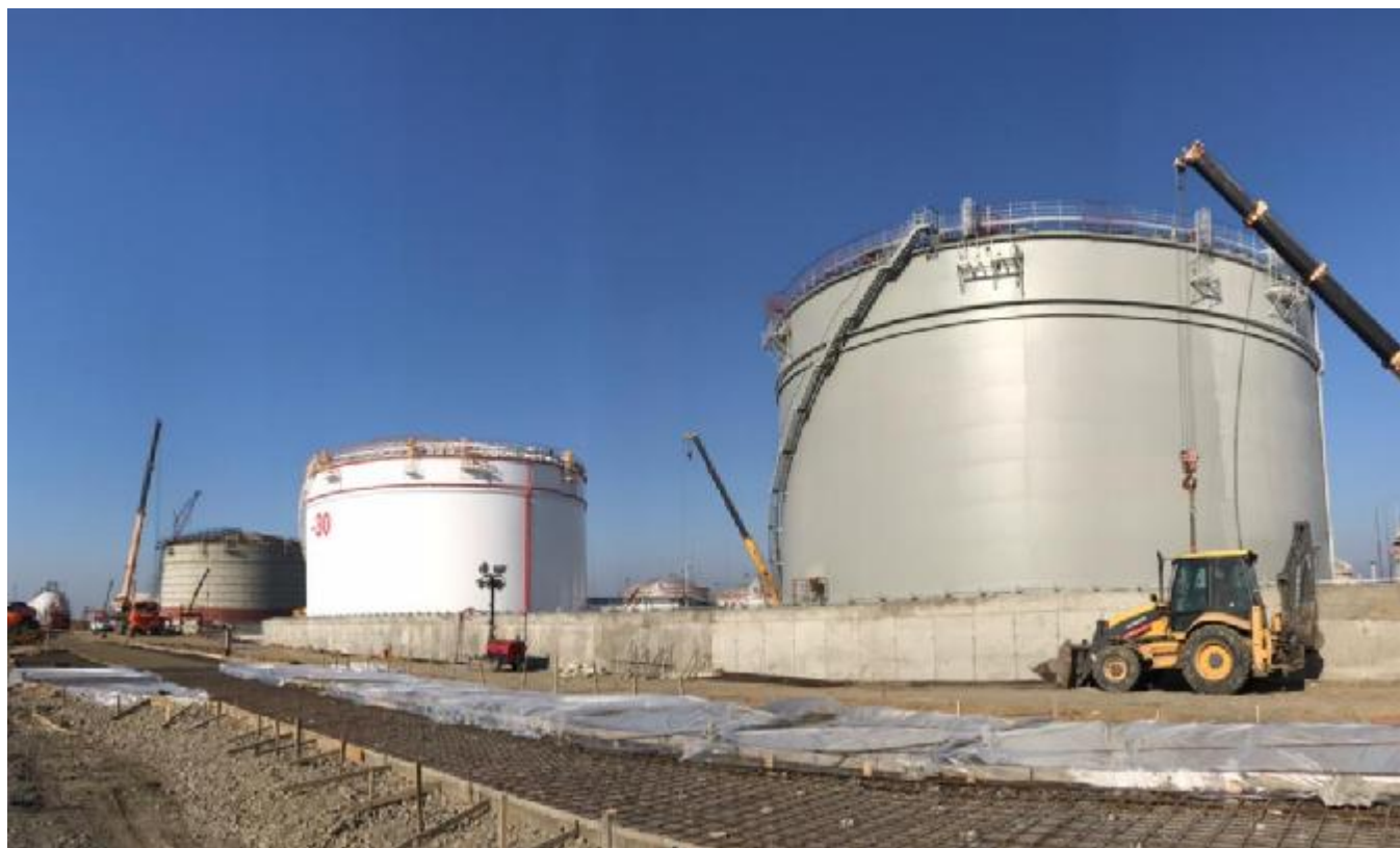
Рисунок 1 - Общий вид резервуаров
