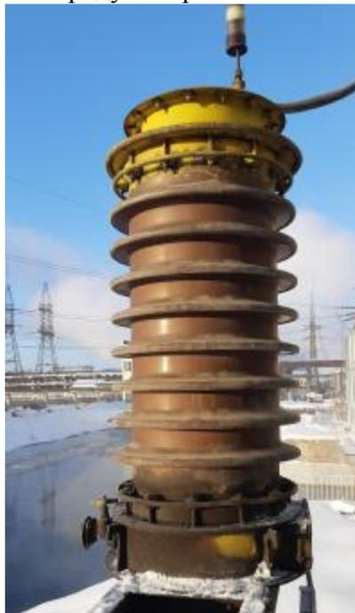
Рисунок 1 – Общий вид трансформаторов напряжения НКФ 110-57
