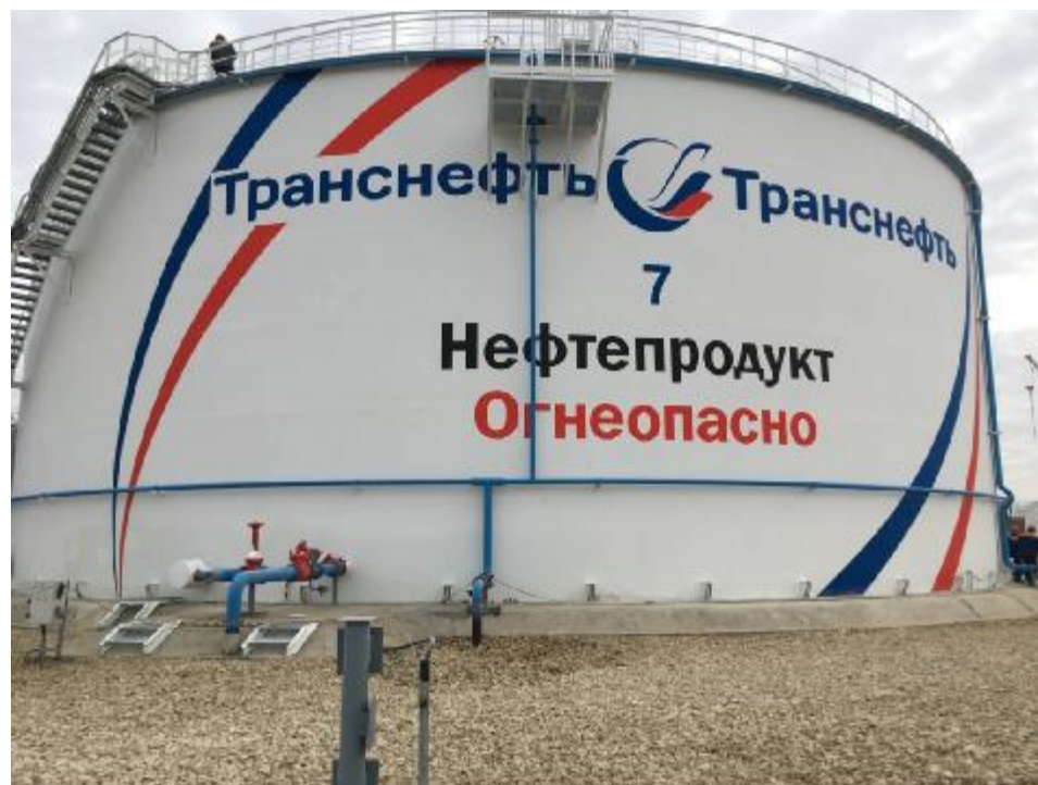
Рисунок 1 – Общий вид резервуара стального вертикального цилиндрического РВС-10000 зав.№ 7
