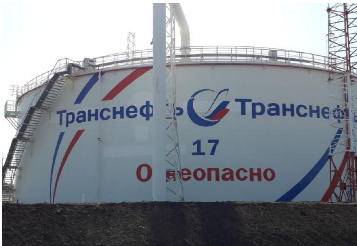
Рисунок 2 – Общий вид резервуара РВС-20000 зав.№ 17
