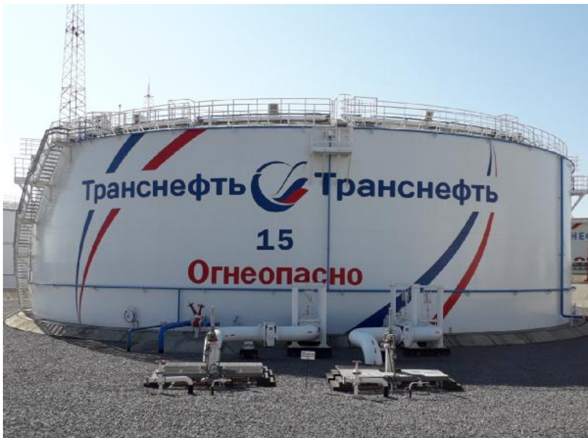
Рисунок 3 – Общий вид резервуара РВСП-20000 зав.№ 15
