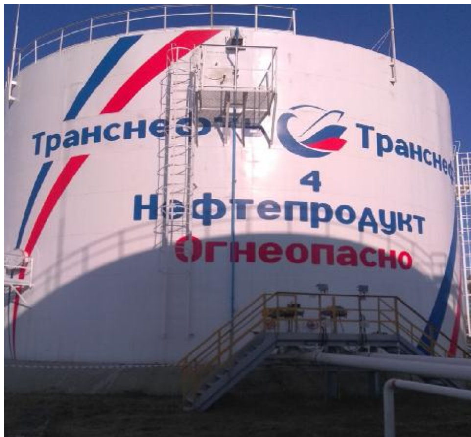
Рисунок 1 – Общий вид резервуара РВСП-3000 зав.№ 4
