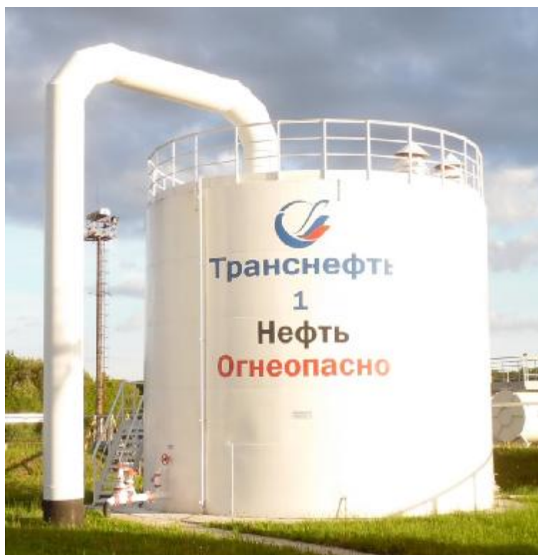
Рисунок 1 – Общий вид резервуара РВС-400 зав.№ 1
