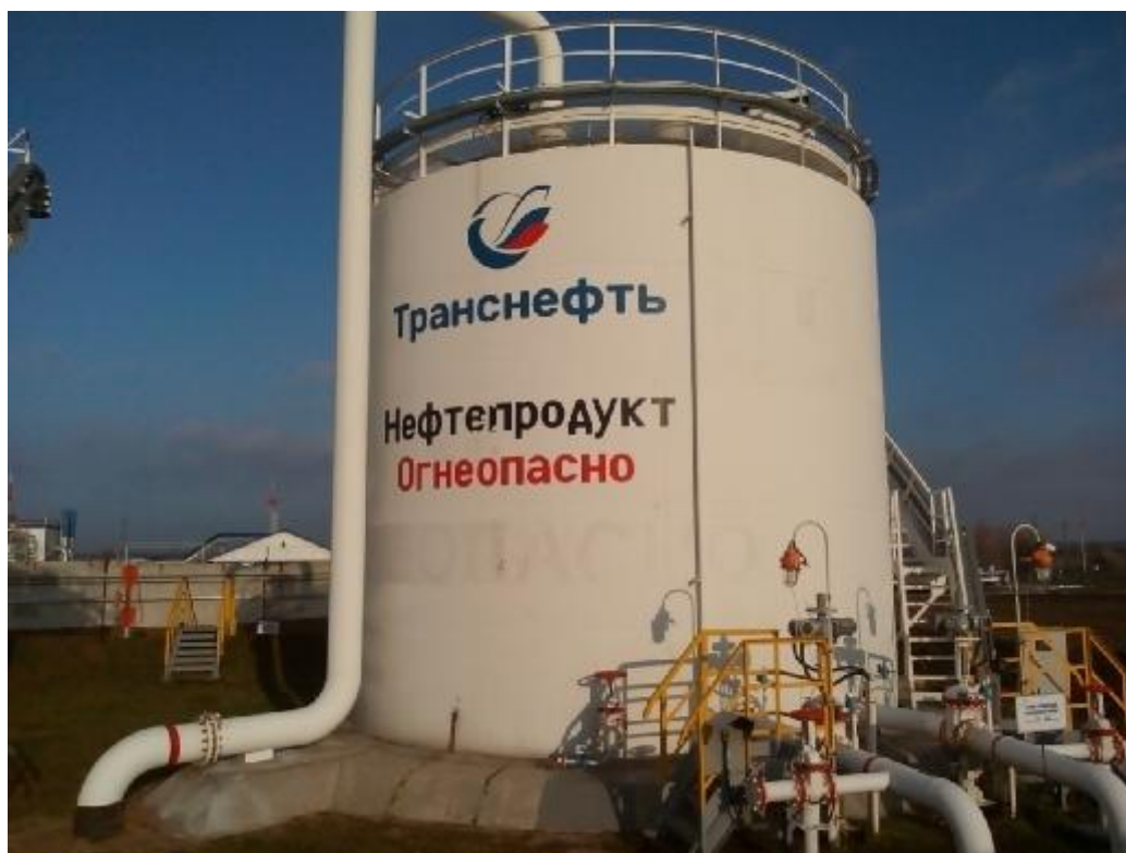
Рисунок 1 – Общий вид резервуаров РВС-400 зав.№№ 22, 23
