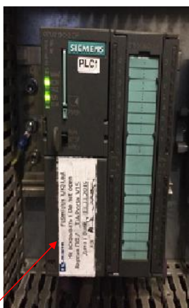
Рисунок 3 – Общий вид Место пломбирования контроллера
