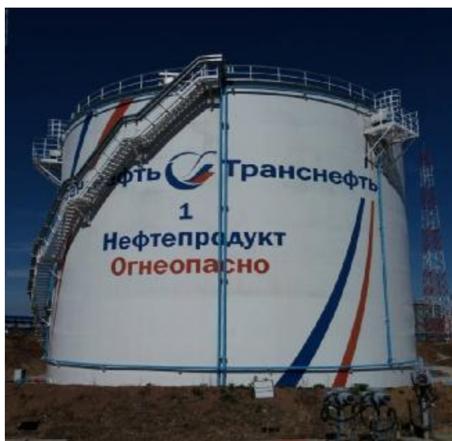
Рисунок 1 – Общий вид резервуара РВС-7500 зав.№ 1
