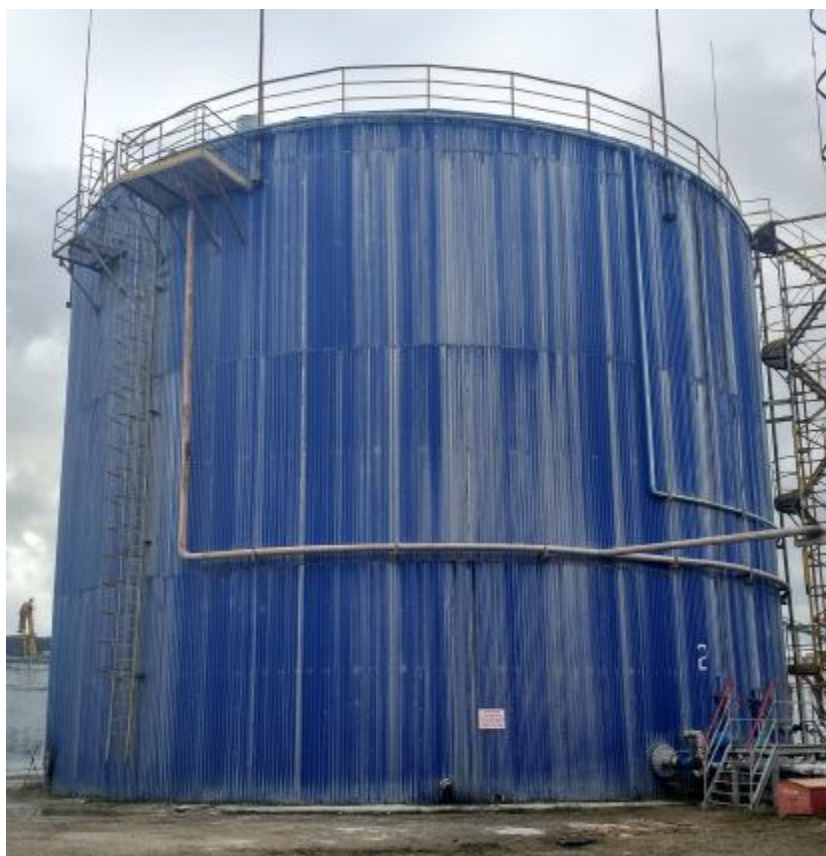
Рисунок 1 – Общий вид резервуаров стальных вертикальных цилиндрических РВС-5000
