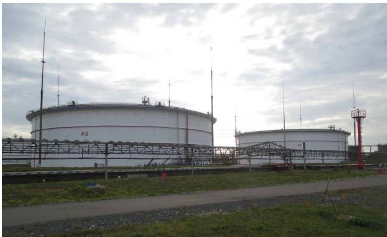
Рисунок 1 – Общий вид резервуаров стальных вертикальных цилиндрических РВСПК-50000
