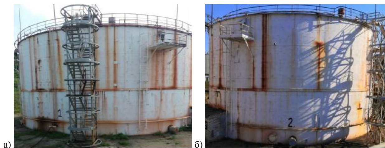
Рисунок 2 – Общий вид резервуара стального вертикального цилиндрического РВС-5000 а) заводской номер 1, б) заводской номер 2
