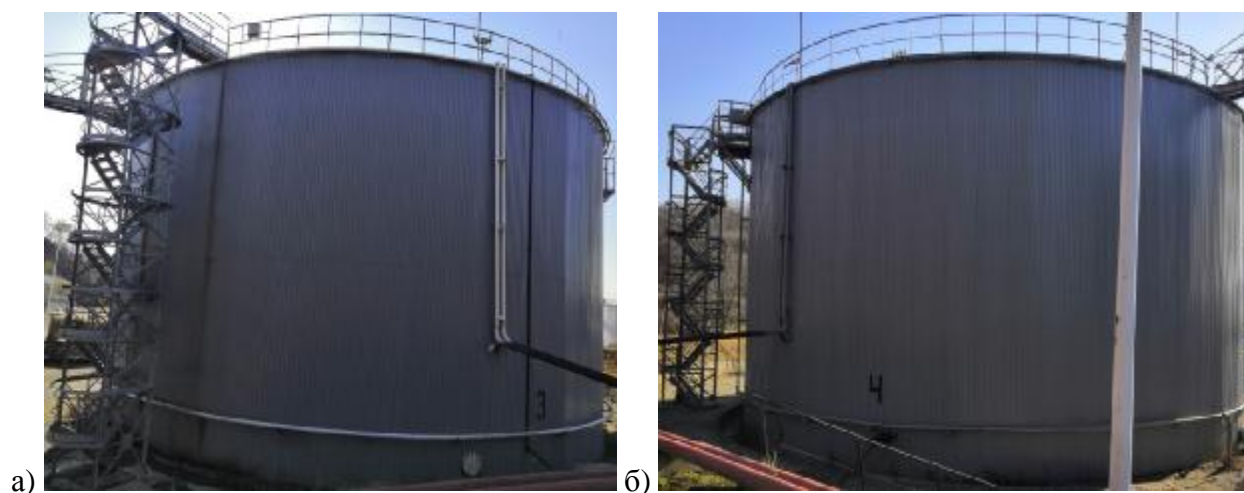
Рисунок 3 – Общий вид резервуара стального вертикального цилиндрического РВС-5000 а) заводской номер 3, б) заводской номер 4
