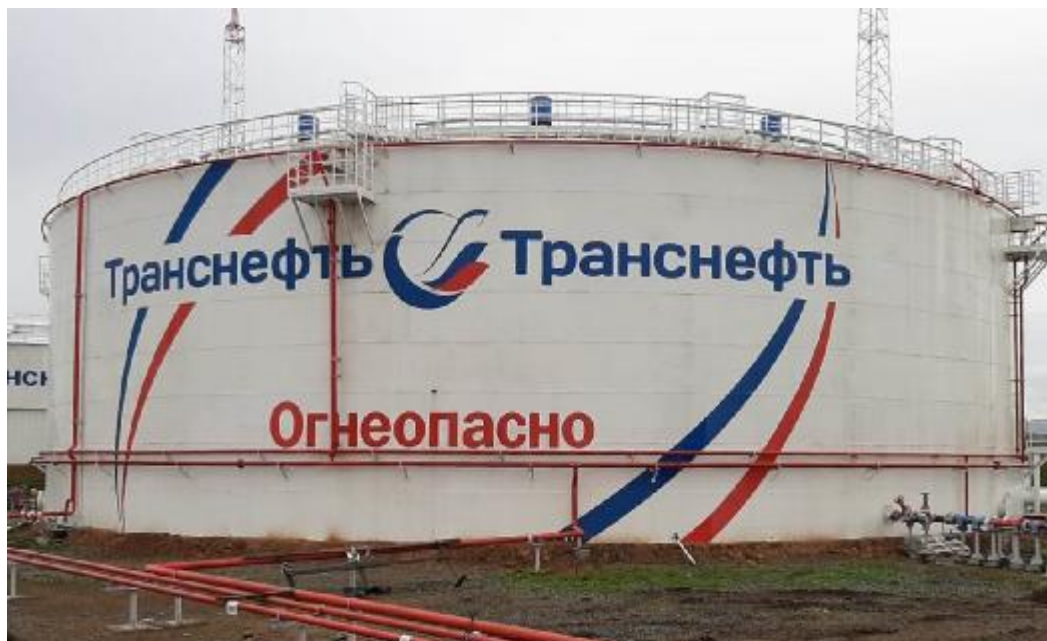
Рисунок 2 – Общий вид резервуаров РВСП-20000 зав.№№ 2, 7
