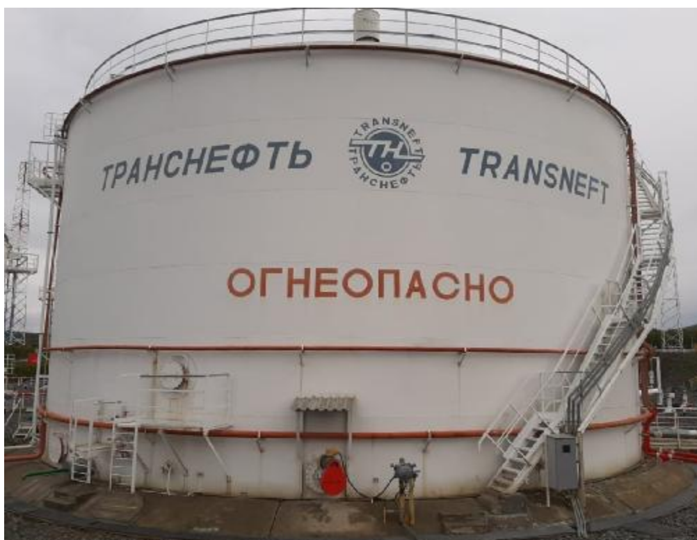
Рисунок 1 – Общий вид резервуаров РВСП-5000 зав.№№ 11, 12
