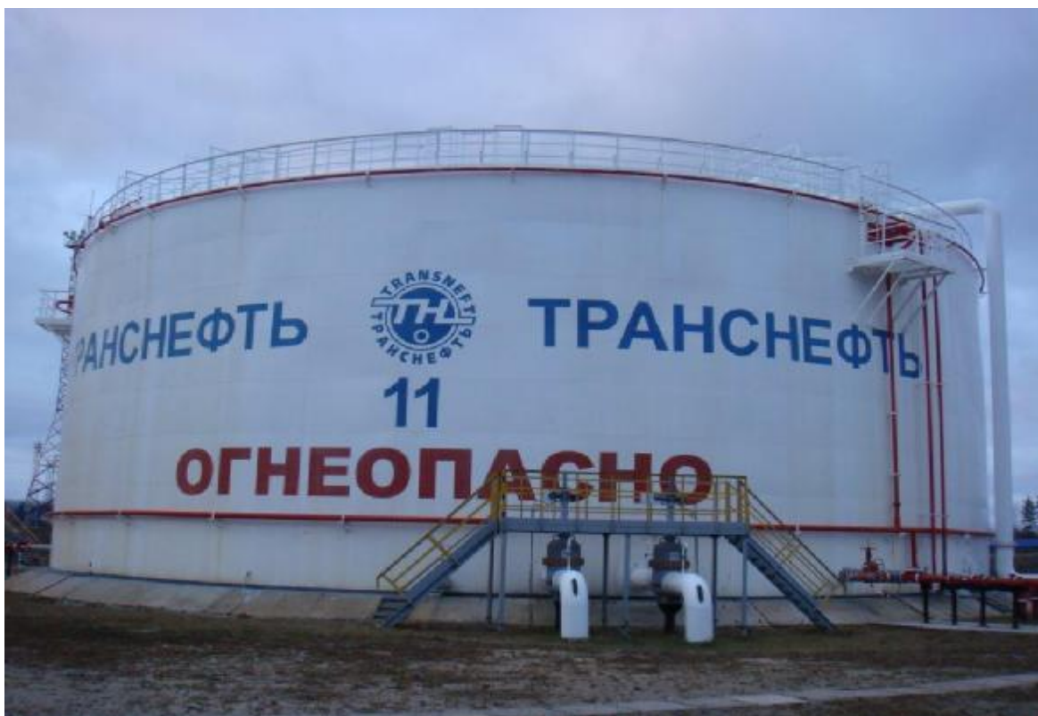
Рисунок 1 – Общий вид резервуара РВС-10000 зав.№ 11
