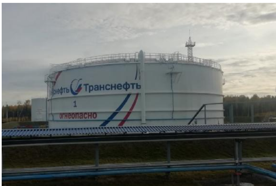
Рисунок 2 – Общий вид резервуара РВС-20000 зав.№ 1
