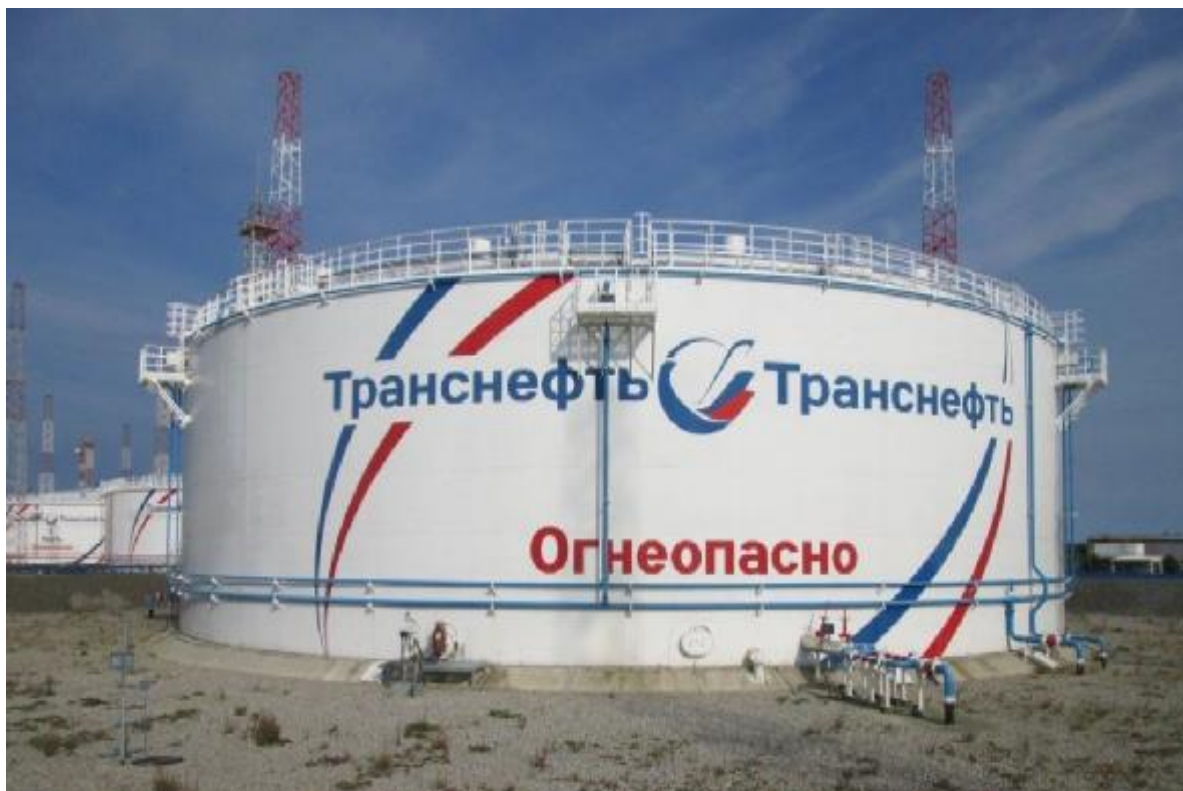
Рисунок 3 – Общий вид резервуаров РВСП-20000 зав.№№ 5, 9, 10, 11, 12
