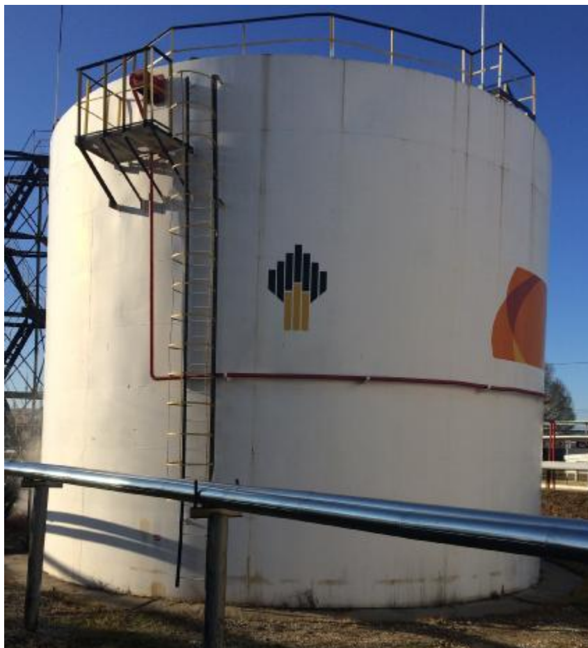
Рисунок 1 – Общий вид резервуара стального вертикального цилиндрического РВС-2000
