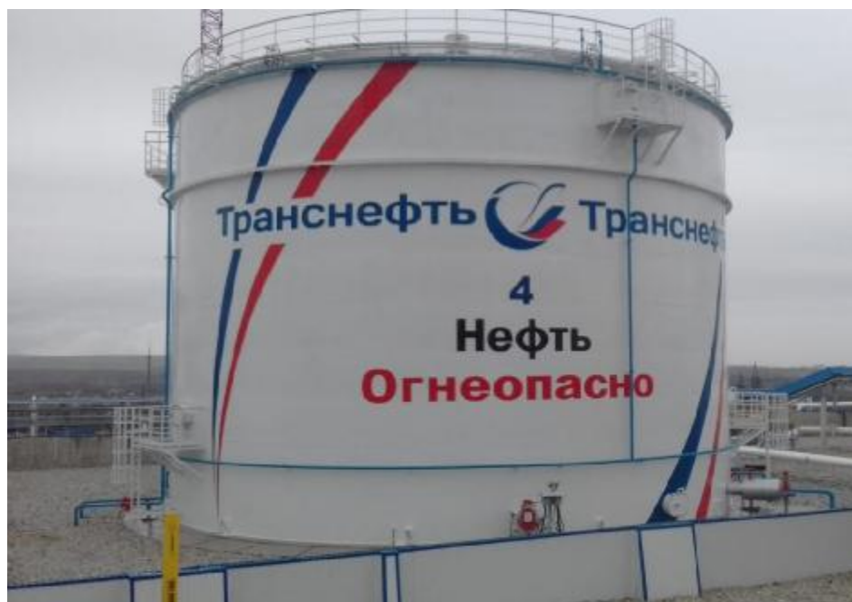
Рисунок 1 – Общий вид резервуара РВСП-5000 зав.№ 4
